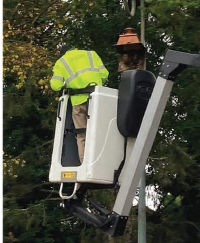
Cette rénovation permet aussi de réparer des raccordements défectueux du réseau, certains candélabres ne s'allumant plus.
