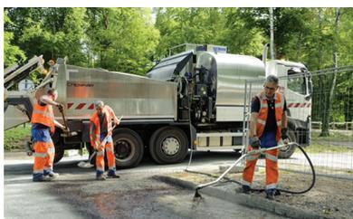
C'était inscrit au budget pour cette année. Des travaux de réfection ont été réalisés sur les voies les plus endommagées de la commune, chemin du Moulin et du chemin de Péreuse. La couche de roulement a bénéficié de l'intervention du PATA, (point à temps automatique), camion équipé d'une cuve calorifugée remplie d'émulsion et d'un bac à gravillons.
